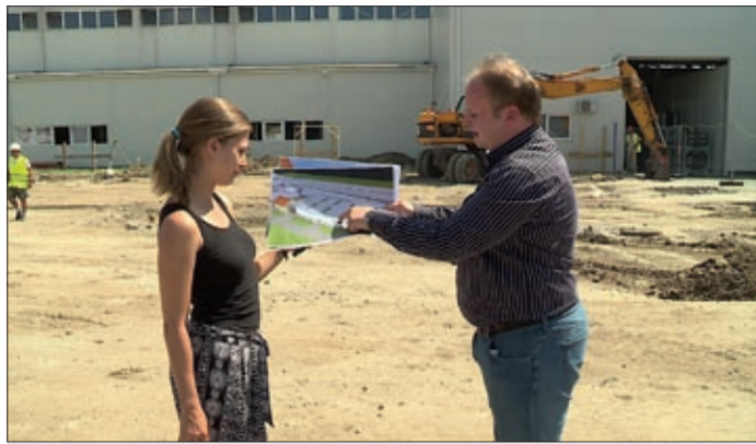
Majoros Csaba az építkezés területén a terveket mutatja
