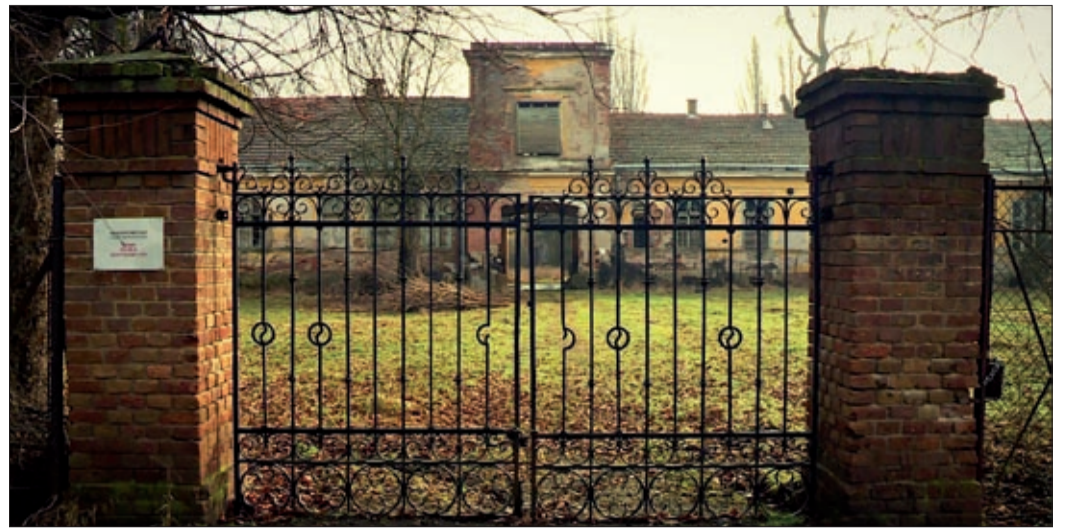
Az épület állaga egyre romlik, legalább 500 millió forint kellene a felújítására
