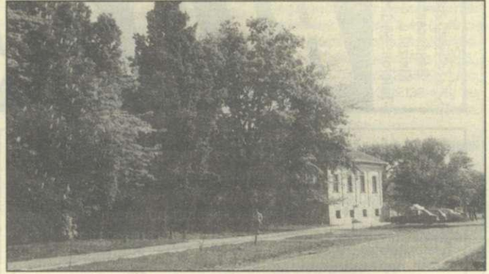
A hajdani első kád- és gőzfürdő épülete ma
