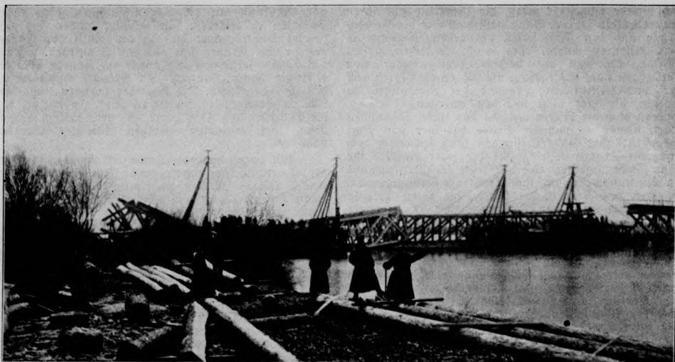
Verstärkte Eisenbahnbrücke über die Warthe bei Eszradz.
