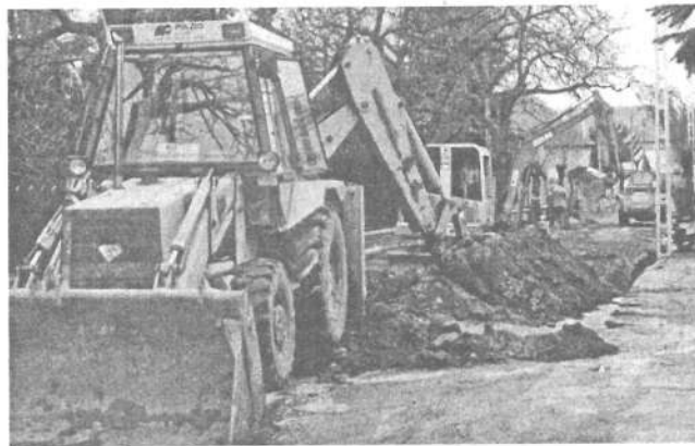
Csatornaépítés a Szegfű utcában Fotó: Rásonyi Gyözőné
