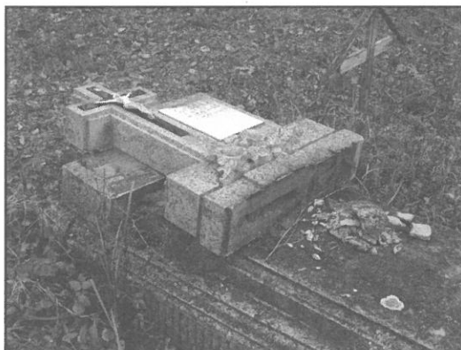
Ezt a sírkövet le kellett fektetni, mert életveszélyessé vált
