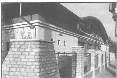
A Szabadság úti óvoda új kerítése
