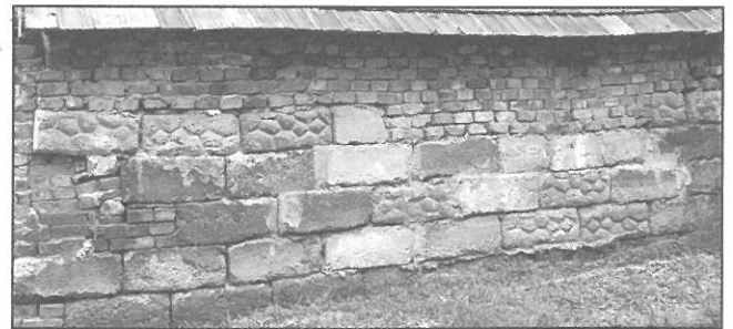
Dolomit falazóblokkból és téglából vegyesen épült melléképület a Rákóczi utcában
