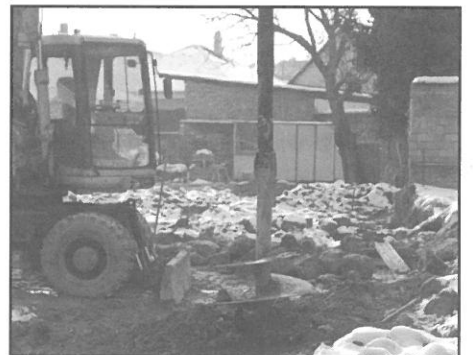
Az épület ún. kútalapozással készül. Képpünkön egy kútalap fúrása látható
