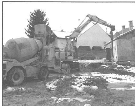
Az Ügyfélközpont és a Házasságkötő terem alapozási munkálatai
