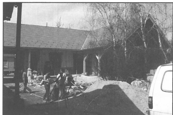
A felújított tető
