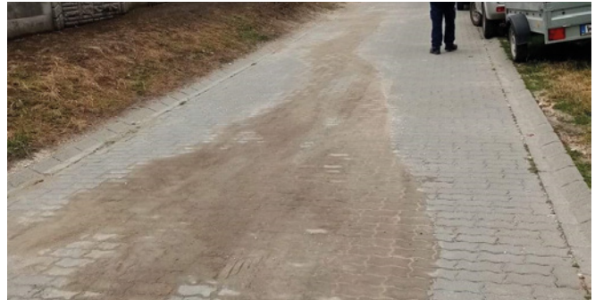
Visszatérően kellett hordalékot takarítani
