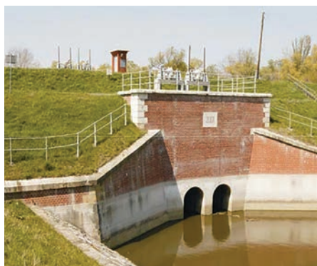
1. a-b kép. Belvízelvezető csatorna kiépített műtárgyai
