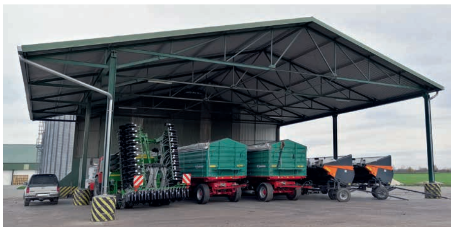
Munkagépek tárolására kialakított vasszerkezetes, nyitott tárolószín
