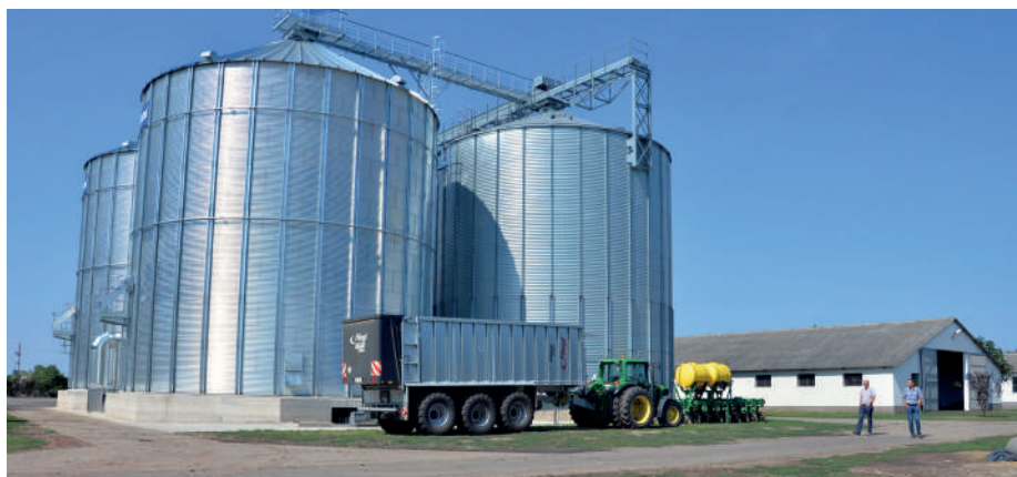
A terménykezelést a kiváló minőségű svéd TORNUM-technológia segíti, aminek tárolókapacitását a közelmúltban 7500 tonnára növelték
