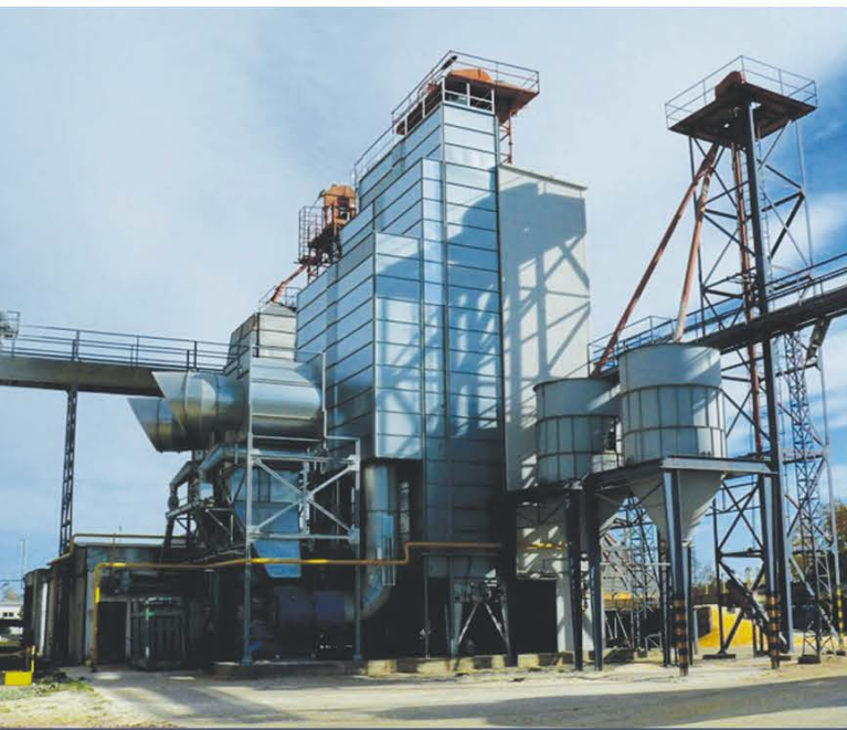
3. ábra: Szárítótelep (pontszerű légszennyező forrás, centrifugál leválasztóval)
