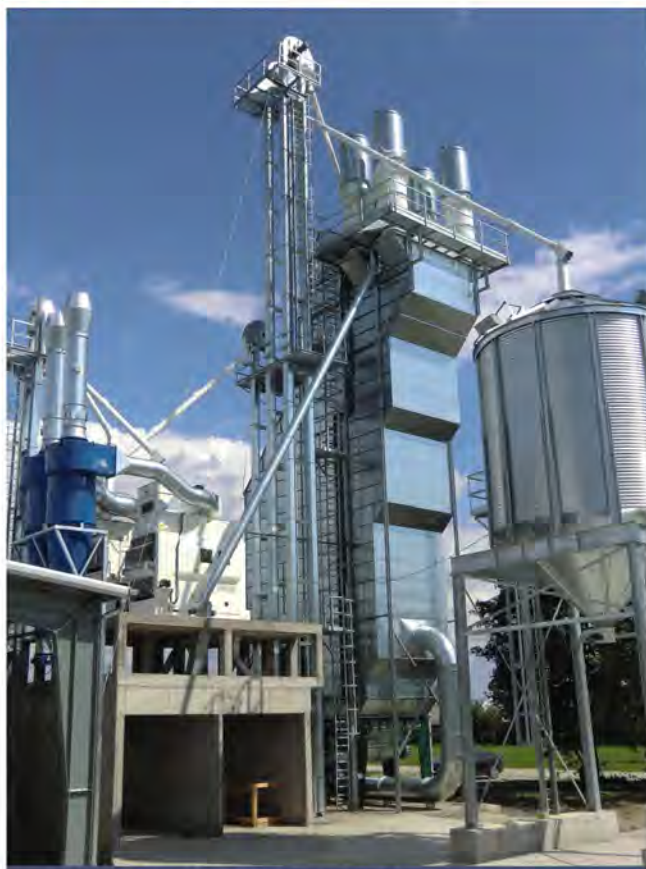
3. ábra: CIMBRIA szárító berendezés (pontszerű légszennyező forrás, Cyklofan leválasztókkal)
