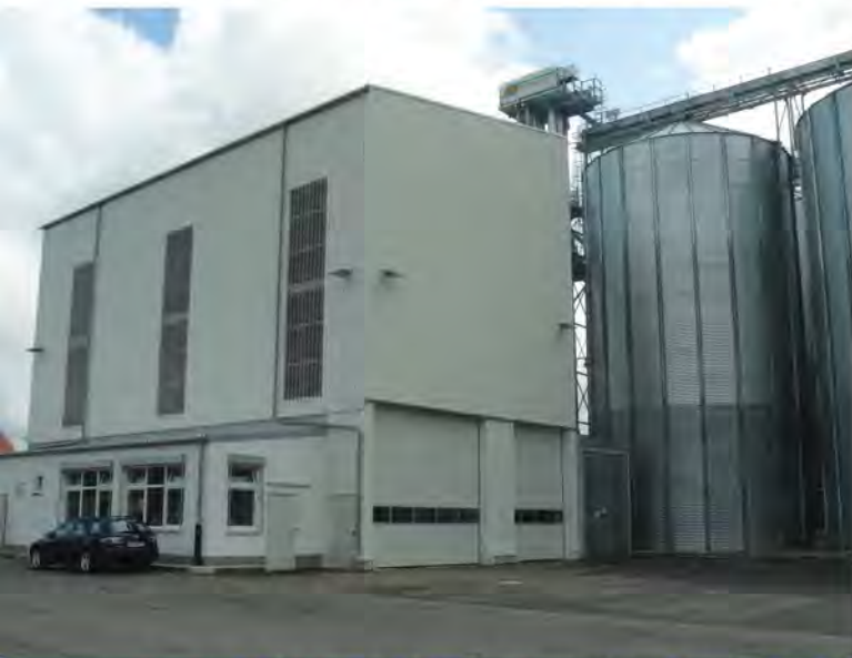
4. ábra: Zárt terményfogadó állomás (NSzK, BAYWA telep)
