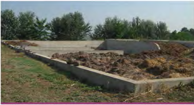
3. ábra: Az előírásoknak megfelelő trágyatelep broileristállók mellett
