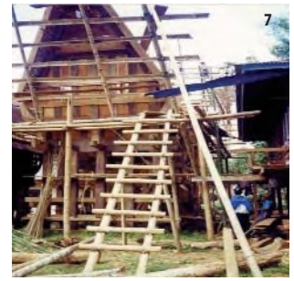
7. Létra készítése az állványokhoz
