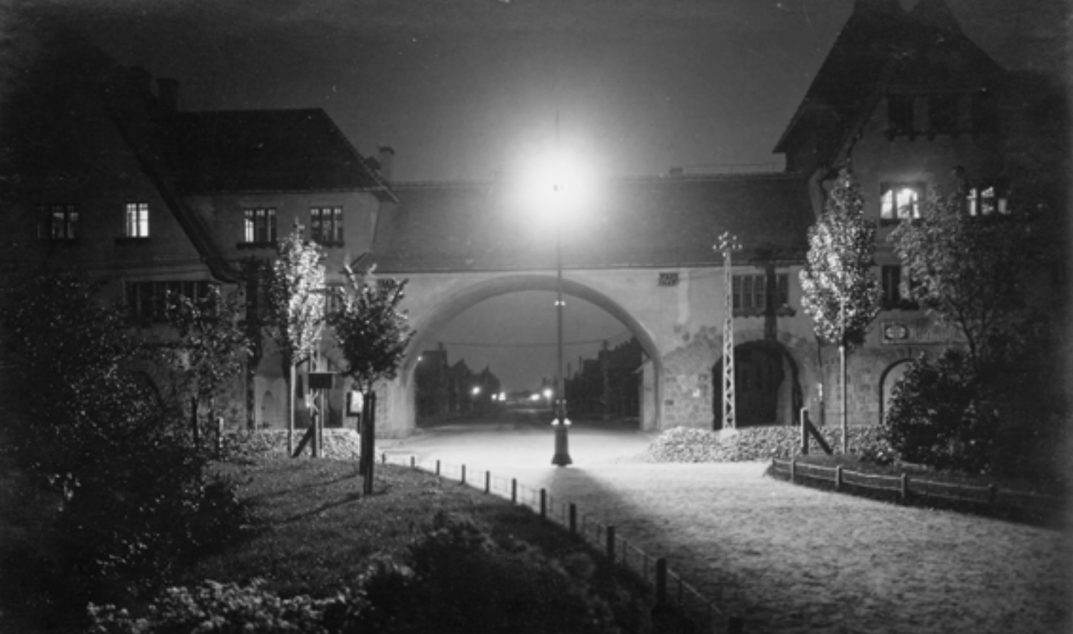
Wekerletelep, Kós Károly (Fő) tér, Kós-kapu a Hungária út felé nézve (1928)
