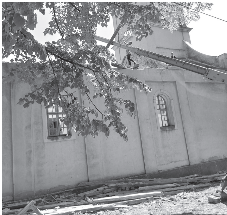
Kívül-belül felújítják az érköbölküti református istenházát
