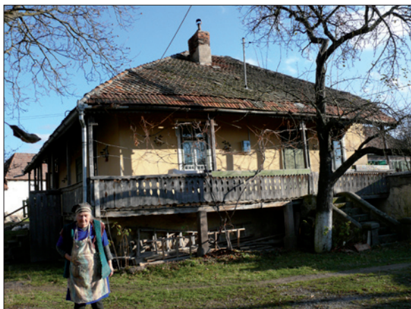
47. ábra Az üvegyár egyetlen ma is álló épülete, az irodaház, ma lakóház (2008, saját felvétel)
