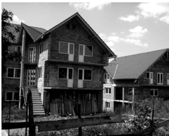
6. kép Viszonteladó korondiak épülő háza a főút mentén
