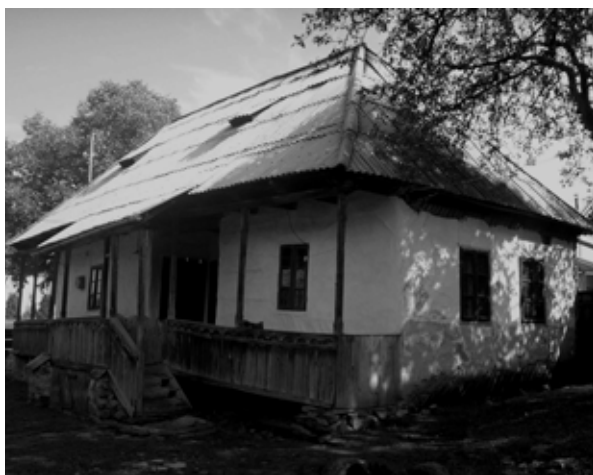
3. kép Térszerkezetét napjainkig megőrző, a XIX. század második felében épített ház (alaprakza a 2. rajz)
