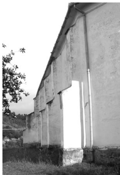
1. Az északi homlokzat támpillérei
