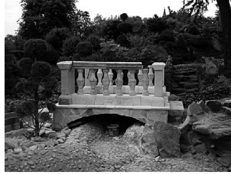
Híd építése a japánkertben, maradék kész kőelemekből hiányzó elemek faragása, 2014
