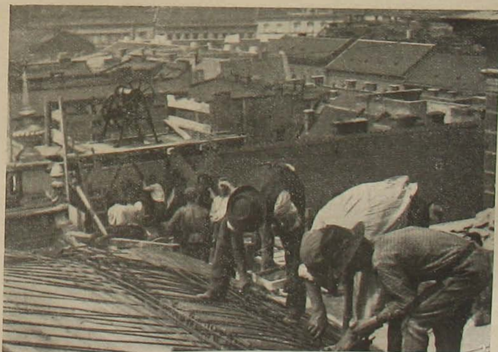
A magyar királyi operaház átalakítása. — A vasbeton vázának szerelése.
