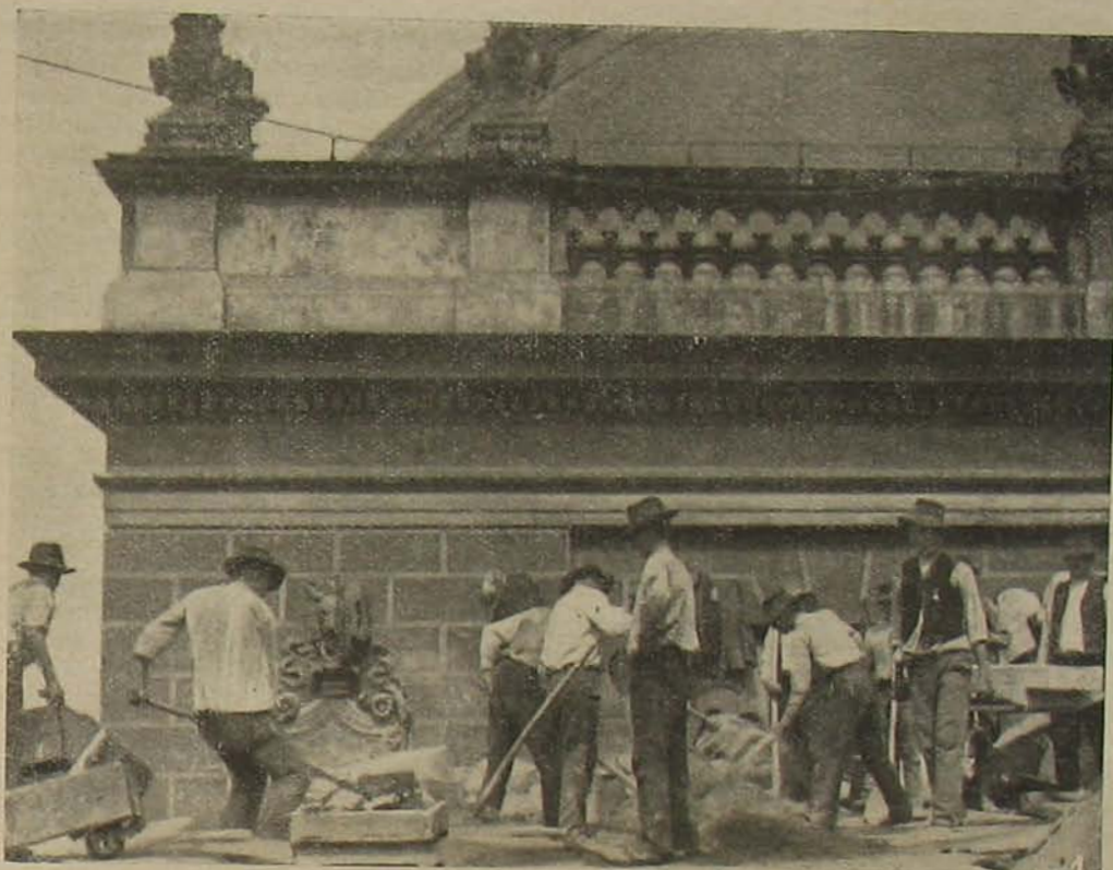
Betonkeverő munkások a tetőn.
