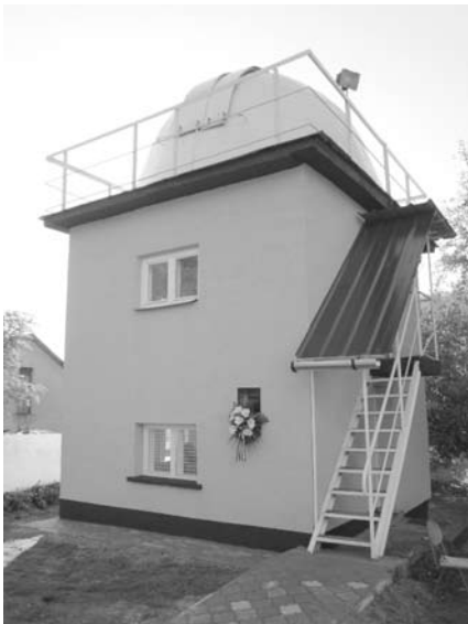
A felújított épület
