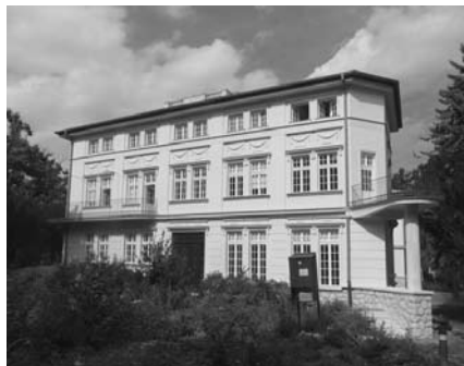
A felújított főépület déli homlokzata
