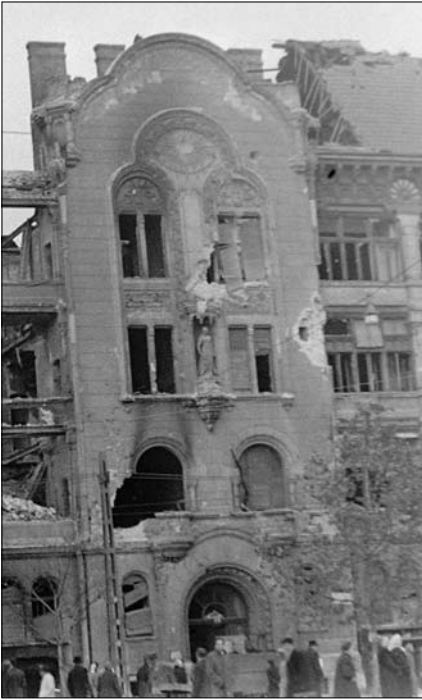
A Mórca Zsigmond körút 2. számú épülete az 1956-os harcok során súlyosan megsérült. Az épület nagy részét nem sokkal később lebontották, rajta a napórával. (Fortepan)
