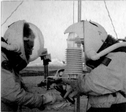
A meteorológiai állomás felállítása
