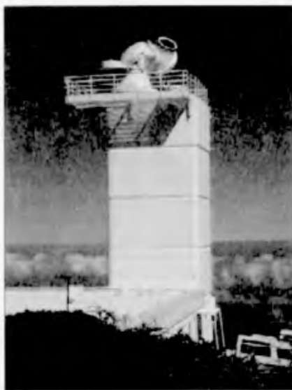
Az 1 m-es Svéd Napteleszkóp tornya, tetején a sziderosztáttal. A 2002 májusában átadott, La Palmán (Kanári-szigetek) található adaptív optikás naptávcső a második legnagyobb leeresztésű távcső a világon, objektívjének tisztá átmérője 97 cm
