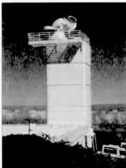
Az 1 m-es Svéd Napteleszkóp tornya, tetején a sziderosztállal. A 2002 májusában átadott, La Palmán (Kanári-szigetek) található adaptív optikás naptávcső a második legnagyobb leeresztésű távcső a világon, objektívjének tisztán átmérője 97 cm.
