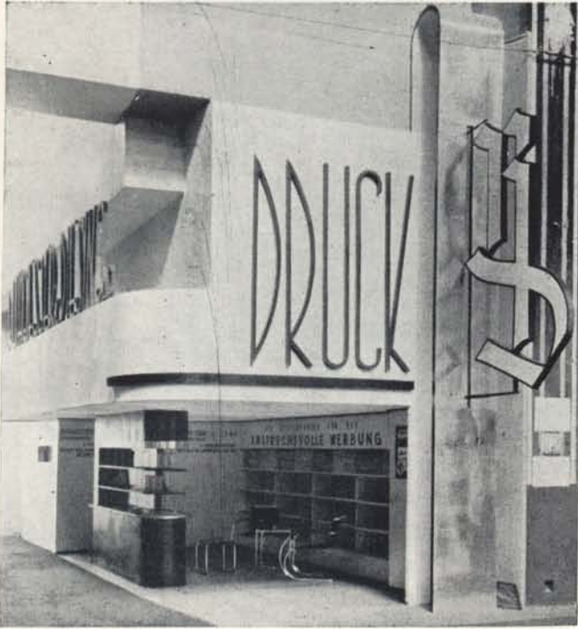
„Rotgiesser & Diesing” könyvnyomda kiállítófülkéje
