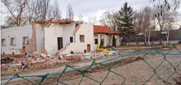
Bontással kezdődött az építkezés.
