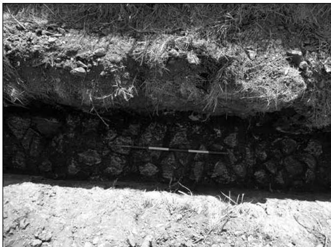
7. kép: Útrészlet az 5b. munkaterületen Fig. 7: Road detail at work site No. 5b
