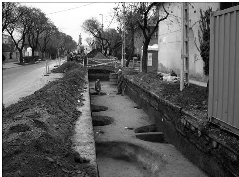
6. kép: Csatorna-közműárok nyomvonalára középső bronzkori objektumokkal feltárás közben (Budapest, XI. ker., Építész utca)
