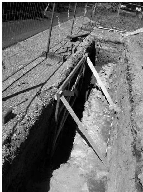
1. kép: Újkori falrészlet (gát?) római kori épületelemekből
