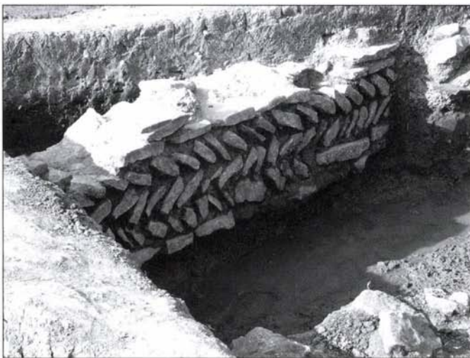
3. kép: Opus spicatum technikával készült falszövet részlete. Fig 3: Fragment of a wall constructed with opus spicatum technique
