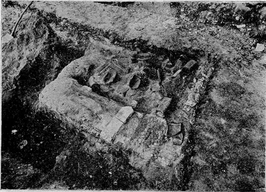
12. sz. kép. A H_1 helyiség fűtőcsövekkel tele.
