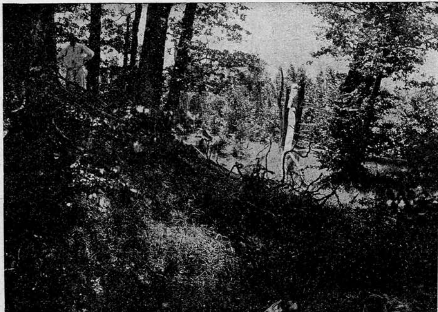
8. sz. kép. Kőtorony maradványai Boronamező, Kásapatak és Perje községek határpontján. Fig. 8 Restes d'une tour en pierres aux confins des villages Boronamező, Kásapatak et Perje.
