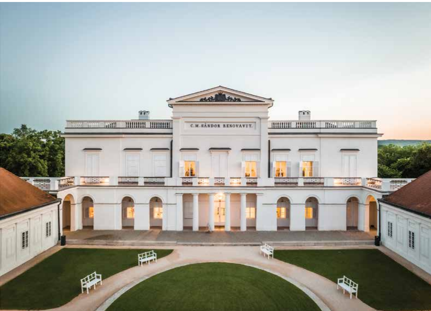
A bajnai Sándor–Metternich-kastély díszudvara. Tervezte: ERŐ Zoltán, a díszudvar és a park helyreállítását tervezte: s73 Kft.
