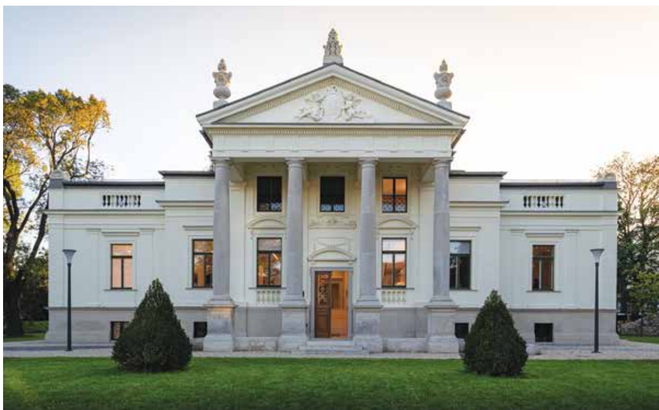
A soproni Lenck-villa bejárata. Az épület tervezője: Otto HOFER | Entrance of the Lenck villa in Sopron. Architect: Otto HOFER | 1890–1892
