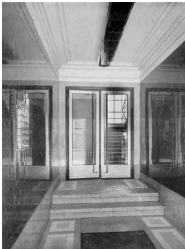
Brack Emil cipőszalon-tulajdonos sarokbérházának előtere (Budapest V. ker., Nyáry Pál utca 5.). Építész: MÜNNICH Aladár | Vestibule of the corner block of shoe salon owner Emil Brack (5, Nyáry Pál st., Budapest Vth district). Architect: Aladár MÜNNICH | 1933–1937
