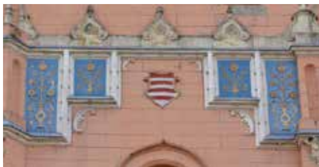
Részlet a főhomlokzat középrizalitjáról majolikamázás pirogránit díszekkel Detail of the main facade with maiolica glazed pyrogranite ornaments Fotó: ifj. Gyergyádesz László
