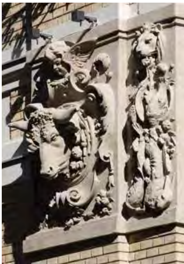
Műkőfaragványok a Hunyadi téri vásárcsarnok oldalhomlokzatáról, Budapest VI. ker., Szófia, egykor Kemniczi utca 12. Pieces of carved artificial stone from the lateral front of the Hunyadi square market hall, Budapest 6, no. 12, Szófia (former Kemniczi) st. Fotó: Nagy Krisztina / MÉM
