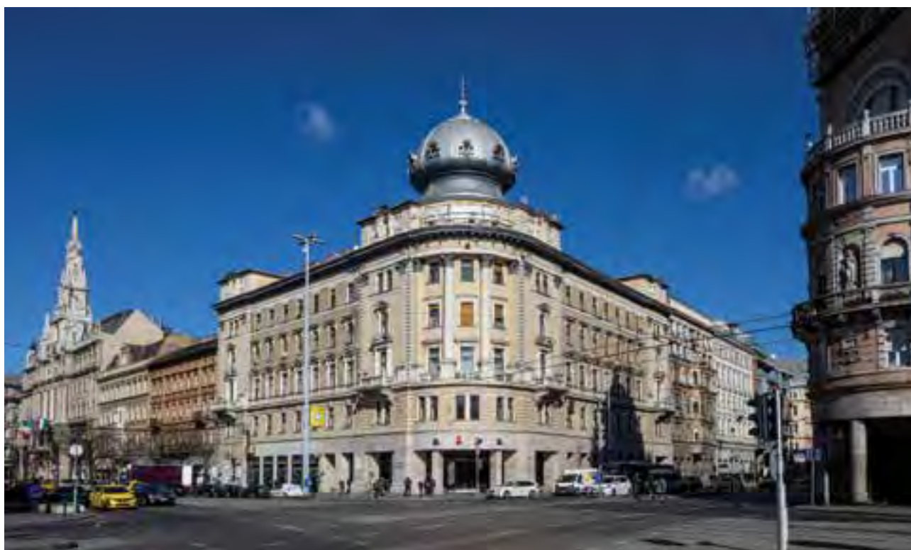
A Pesti Hazai Első Takarékpénztár erzsébetvárosi palotája, Budapest VII. ker., Erzsébet körút 1–3. Erzsébetváros palace of the First National Savings Bank of Pest, Budapest 7, no. 1–3, Erzsébet circular rd. Fotó: Nagy Krisztina / MÉM
