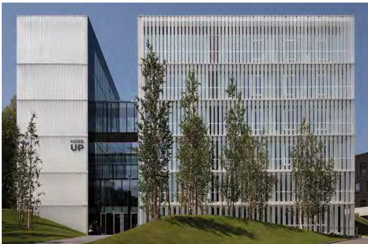
3h Építésziroda: MOME UP (Innovációs Központ, Doktori Iskola, Könyvtár) | 3h Architecture: MOME UP (Innovation Centre, Doctoral School, Library) © MOME, fotó: Bujnovszky Tamás
