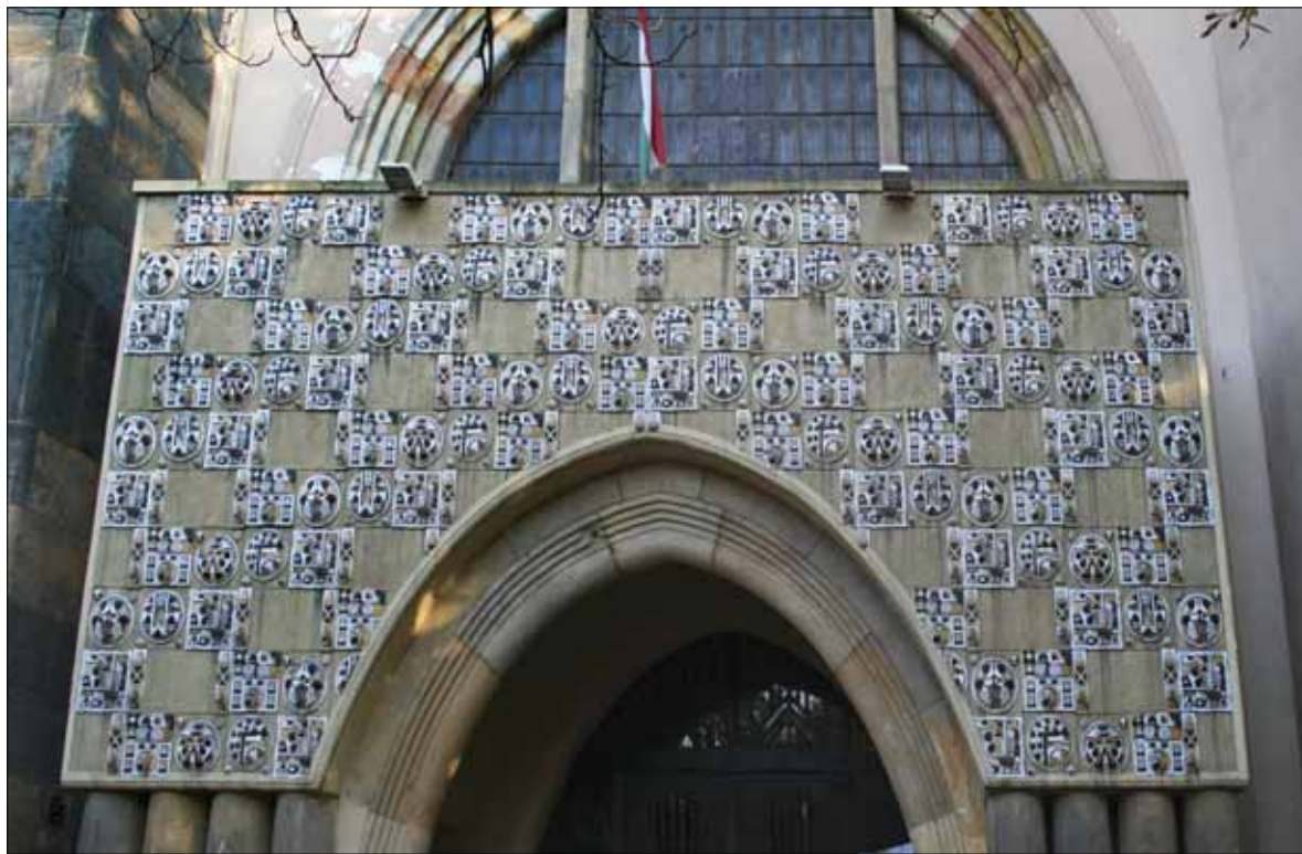
Városligeti fasori református templom, főhomlokzat (részlet), Budapest. Zsolnay kerámiával burkolva. Építész: Árkay Aladár / Main front (detail). Calvinist Church, Városliget Avenue, Budapest. Covered with Zsolnay ceramics. Architect: Aladár Árkay [1913]
