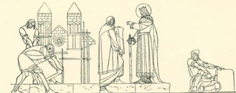
A NAGYVÁRADI SZÉKES- EGYHÁZ ÉPÍTÉSE.
