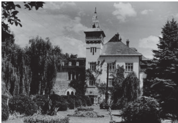
Vlagyimir Mihajlov: A Beregszászi Borüzem épülete
